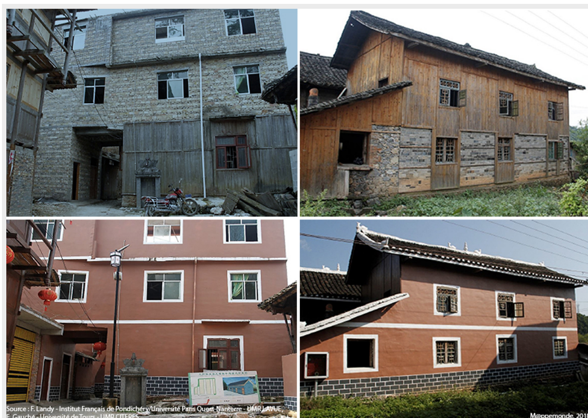
Photos 3 à 6. Avant/après : le nouvel habillage des maisons.
