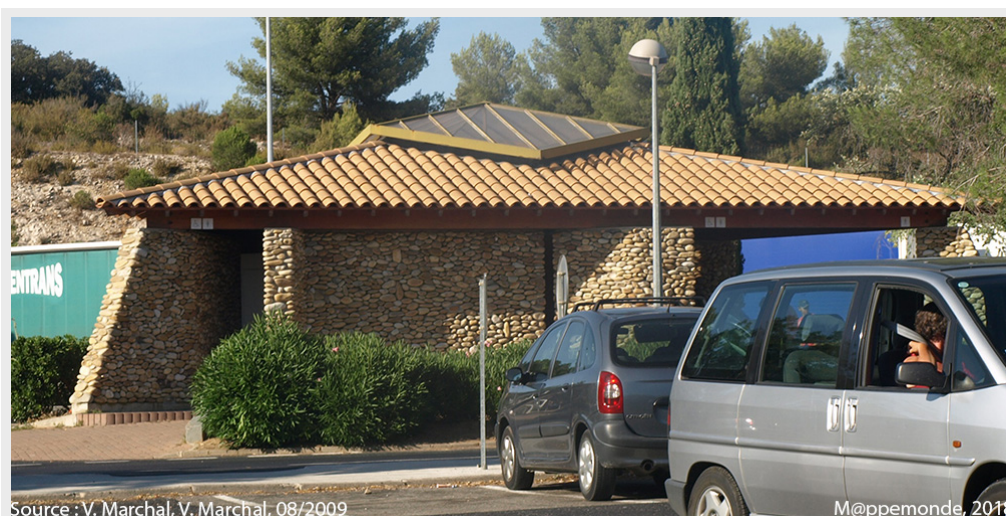
Photo 9. Murs en galets roulés, tuile-canal sur l'aire de Lançon. De Lyon à Marseille, l'architecture des sanitaires ne connaît que des variations mineures. Cliché V. Marchal, août 2009.
