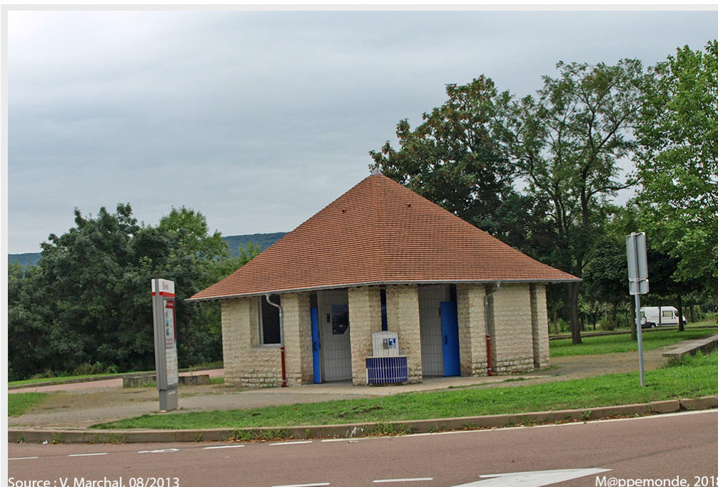
Photo 8. Sanitaires sur l'aire de Jugy, au sud de Chalon-sur-Saône. Tuile plate et forte pente sont encore typiques de la Bourgogne du nord. Cliché V. Marchal, août 2013.
