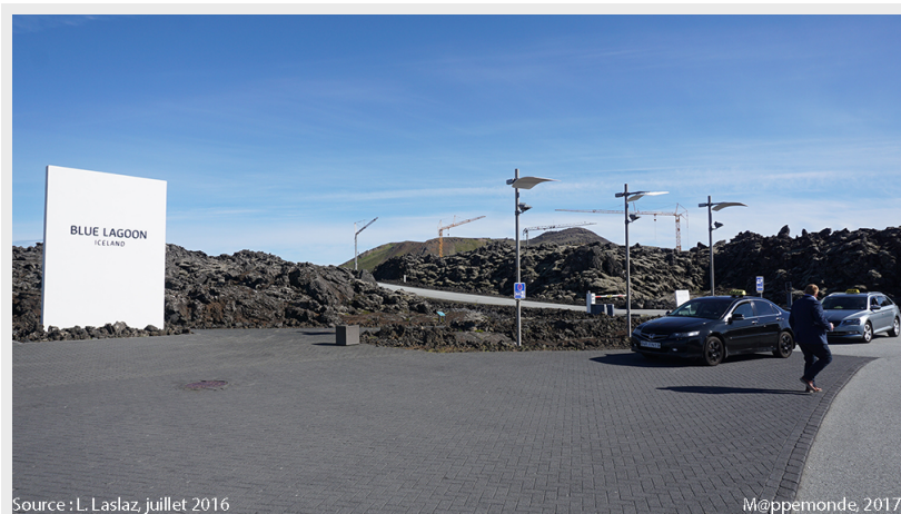
Photo 8. Les travaux d'extension du parking, la construction d'un spa et d'un hôtel de luxe ouverts en 2017 se devinent à travers les quatre grues en arrière-plan. © L. Laslaz, juillet 2016.
