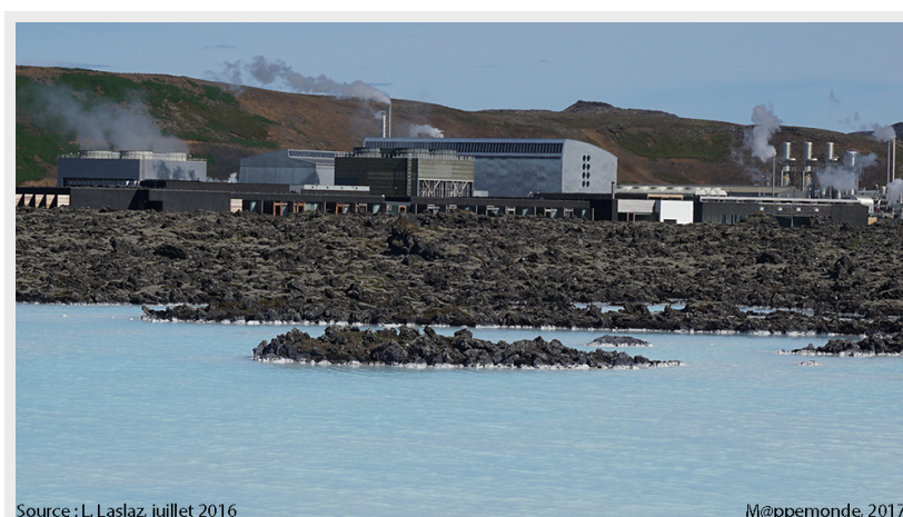
Photo 2. L'usine géothermique de Svatsengerdi (visible par son panache de
