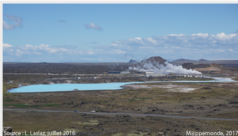
Photo 4. Reykjanes Power station ou Power Plant Earth, sur la péninsule de Reykjanes, sud-ouest de l'Islande. © L. Laslaz, juillet 2016.
