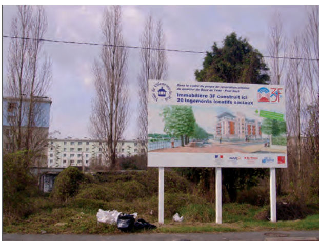
10. La rénovation de la cité Paul-Bert à Villeneuve-le-Roi (cliché : S. Beucher, 2008)
